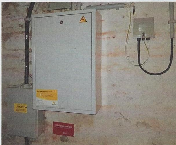
**Hausanschlussverstärker sind beim Internet per TV-Kabel in Mehrfamilienhäusern essenziell, weil das Signal bei vielen Abzweigdosen andernfalls zu stark abfällt. Sie hängen jedoch meist mit am Allgemeinstrom; wird dieser bei Bauarbeiten abgestellt, ist die Internetverbindung weg.**
